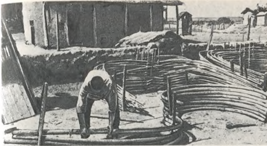
Тез. Изготовление каркаса юрты
